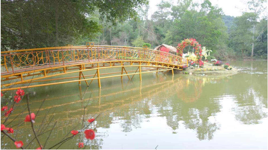
Ảnh 19: Cây cầu sắt lấy ý tưởng đám mây vút lên trời dẫn vào điểm “Đầu chân thánh Gióng” được xây dựng năm 2023
