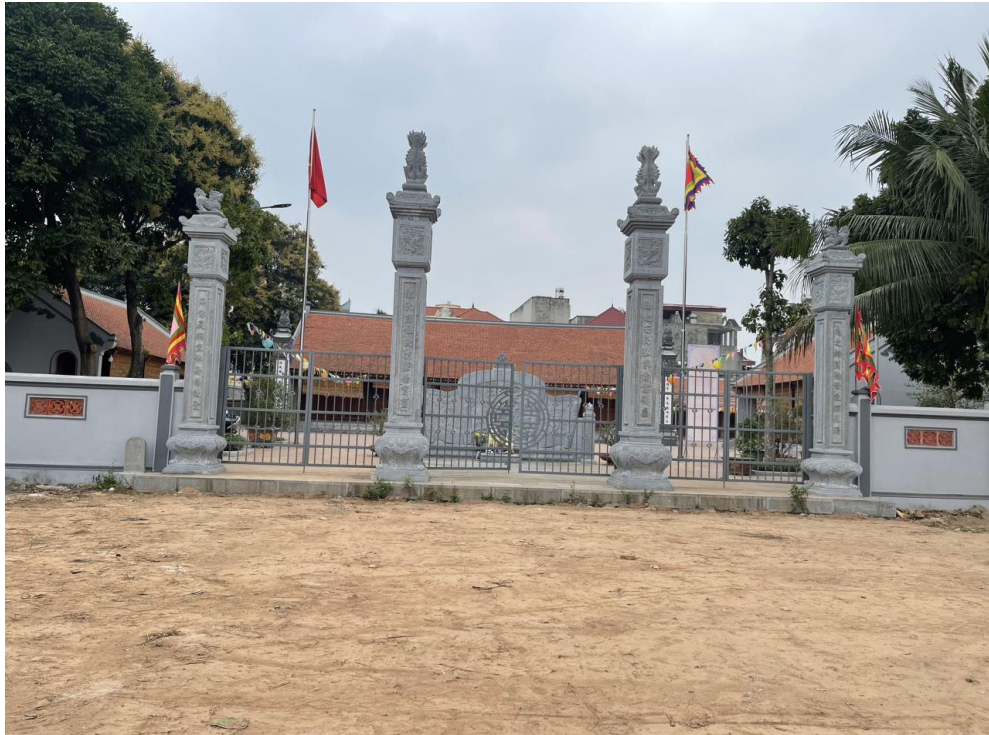
Hình 5.3: Cổng đình Linh Đàm sau khi được trùng tu năm 2022 Nguồn: Tác giả chụp ngày 21/2/2023
