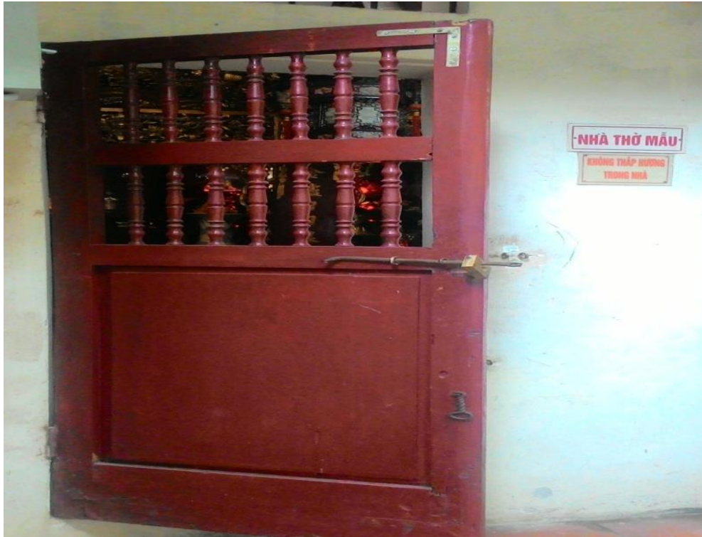
4.4. Cánh cửa ở nhà Mẫu có hiện tượng môi và bị lung lay
