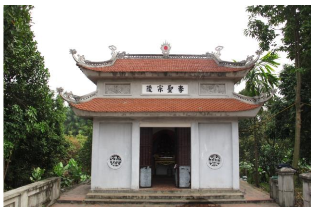
H.3: Lăng mộ vua Lý Thánh tông
